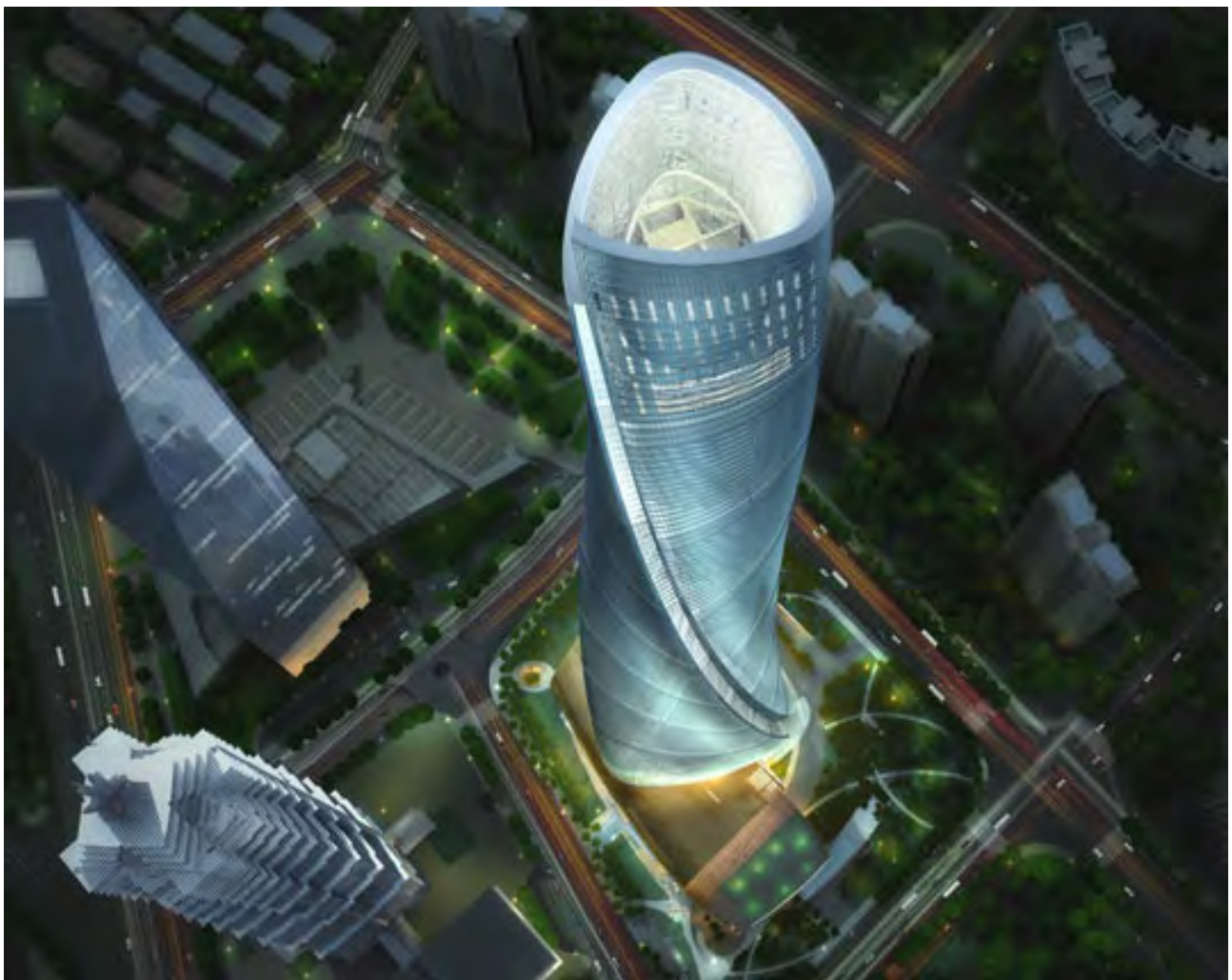
Fig.3 Shanghai Tower, Gensler, in corso di costruzione.
