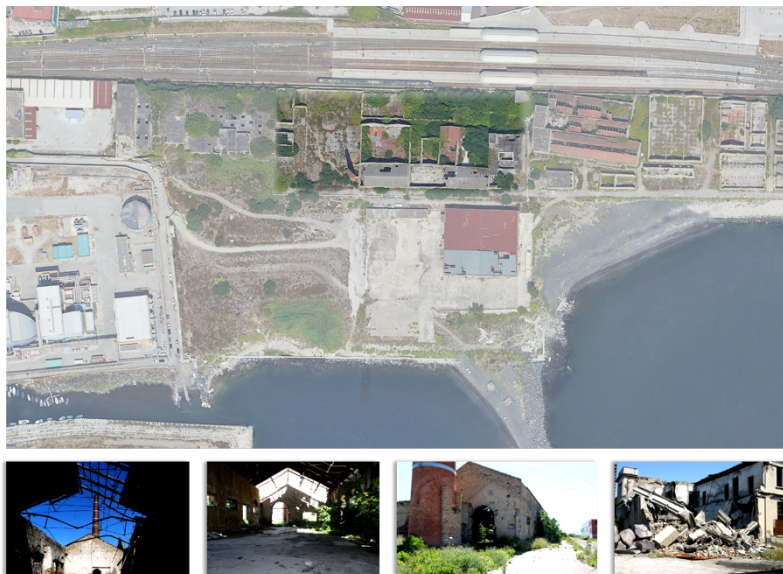
(Fig. 3) Area ex-industriale Corradini, San Giovanni a Teduccio, Napoli. In evidenza, il versante orientale (Lotto 1) oggetto della ricerca.
